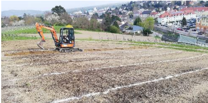
Abbildung 65: Streifenförmiges Rigolen der vorgesehenen Pflanzstreifen mittels Bagger nach der Ausbringung von Kompost und vor der Rebenpflanzung
