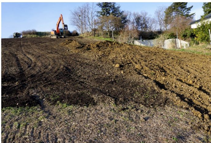
Abbildung 64: Rigolen mittels Bagger nach der Vorratsdüngung und vor der Rebenpflanzung in eine Tiefe von bis zu 60 cm
