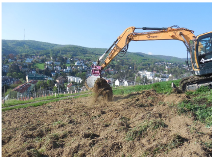
Abbildung 63: Rigolen mittels Bagger nach der Vorratsdüngung und vor der Rebenpflanzung in eine Tiefe von bis zu 60 cm
